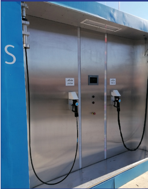
5. ábra: Kompresszor és töltőoszlop a Linde magyarországi töltőállomásán [forrás: saját felvétel]
