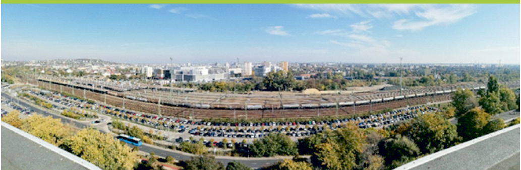
6. ábra: 738 m hosszú kísérleti tehervonat Budapest-Kelenföld állomáson 2021. 10. 20-án (forrás: KTI, fotó: Virág Álmos)
