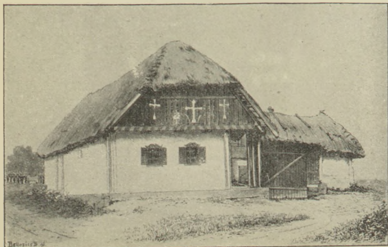
Fig. 8. Haus in Szombatta. Gassenansicht.
