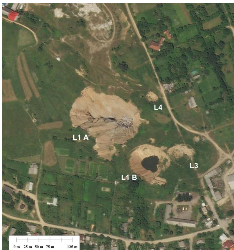
12. ábra: A Lajos-bánya feletti töbrök a 2012. 07. 04-én készült Google műhold felvételen Fig. 12: Sinkholes on the area above the Lajos salt mine on the Google satellite image 24. 07. 2012
