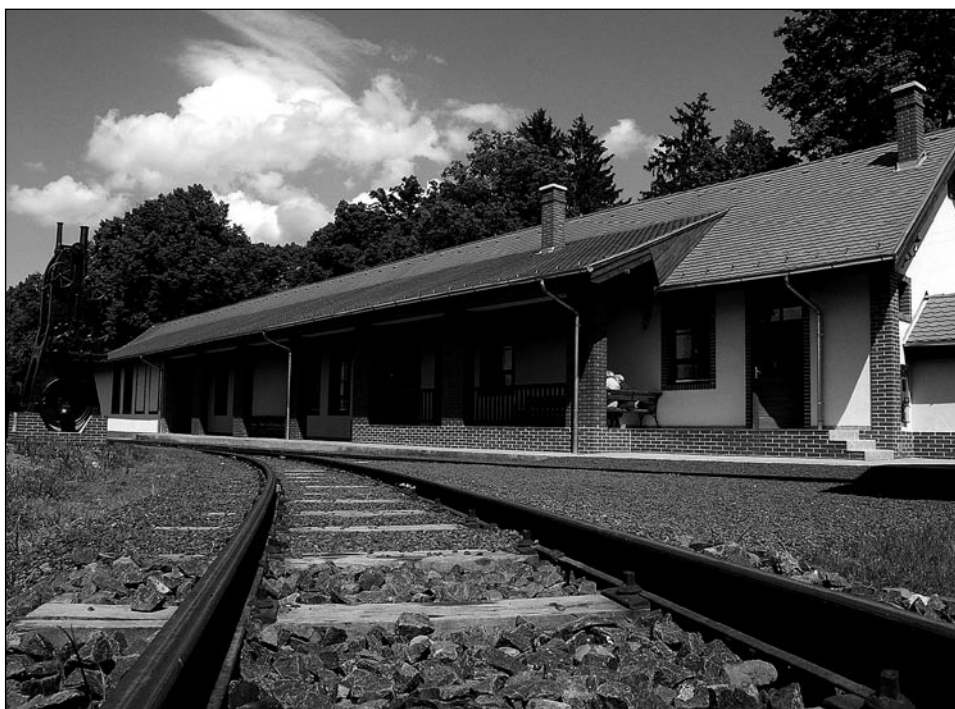
Az állomás épülete – The building of the station
