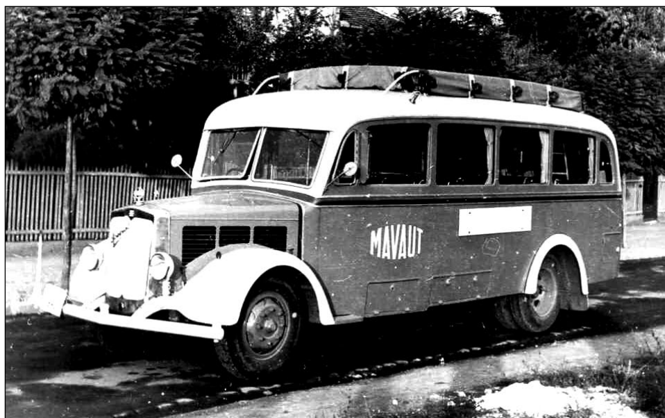
Rába Special 30 személyes autóbusz 80 LE-s (58,8 kW) dízelmotorral 1938-ban The Rába diesel bus able to seat 30 passengers, 1938
