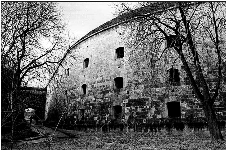
Részlet az erődrendszerből – Detail of the fortification system
