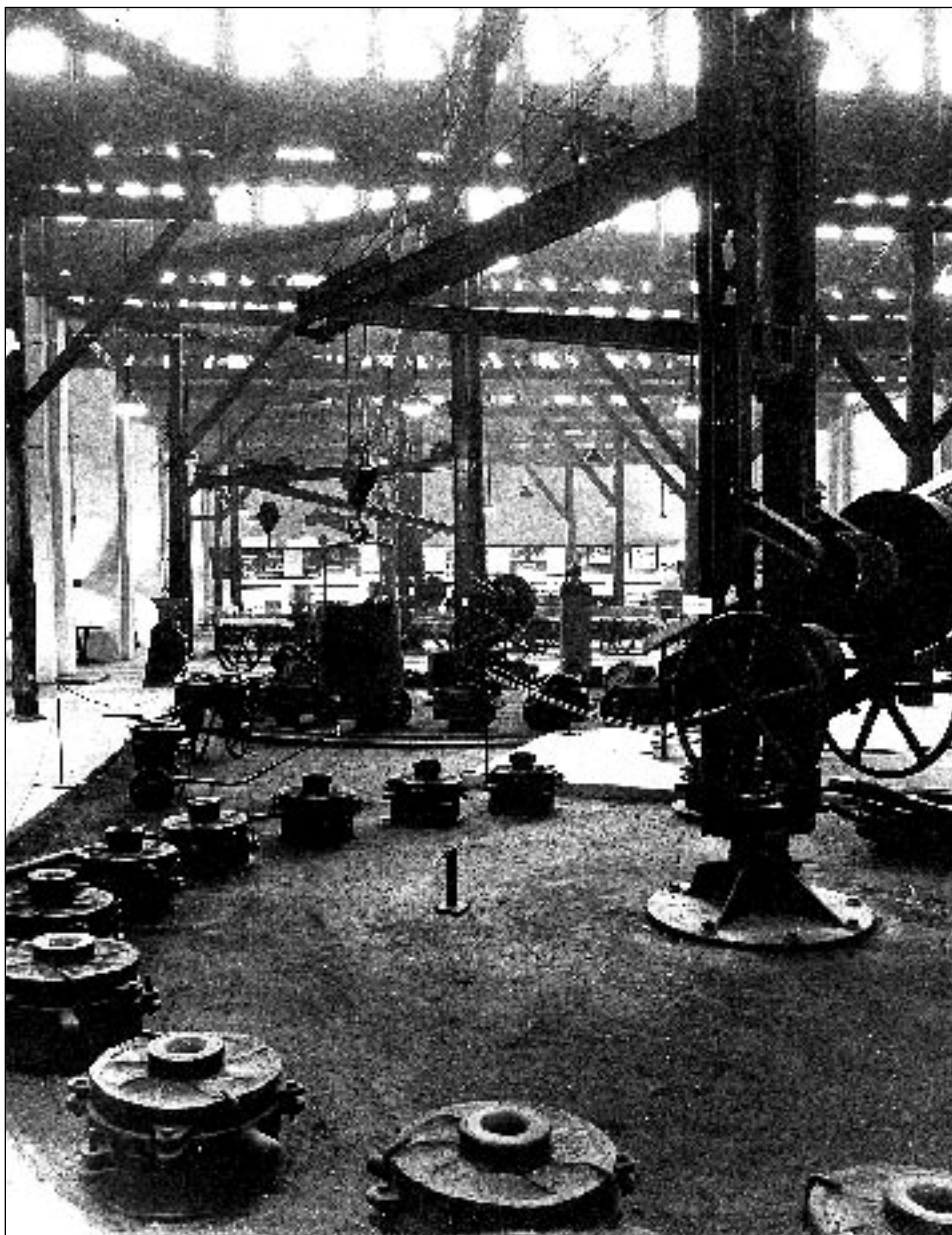
Részlet a műemléki kiállításról, a forgódaru alatti formázókör A detail of the memorial exhibition: the moulding circle under the slewing crane
