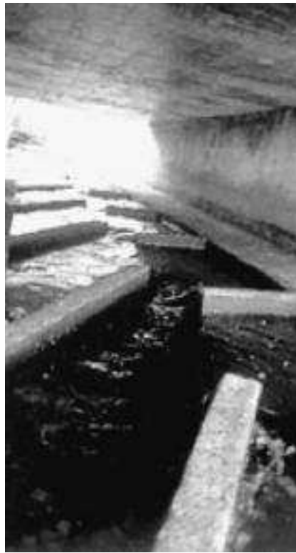
Denil-féle hallépcsők „halszállás kialakítású” (bal) és egy „szuperaktív” terelőlemezekkel ellátott típus (jobb) (Larnier és mtsai, 2002 nyomán)
