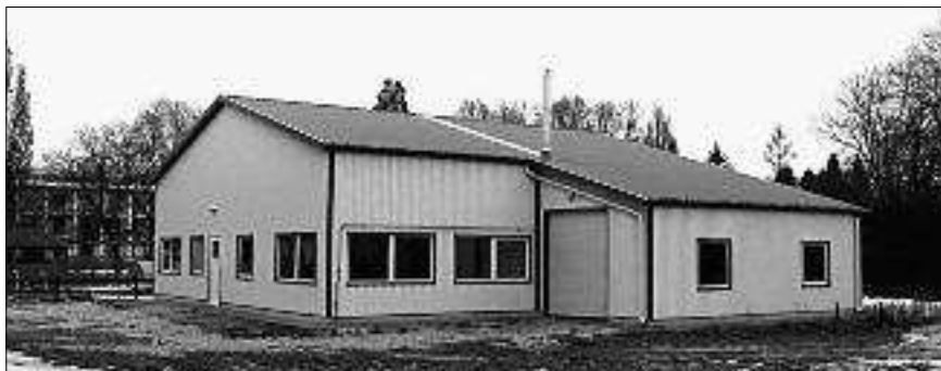
A halászati laboratórium épülete
