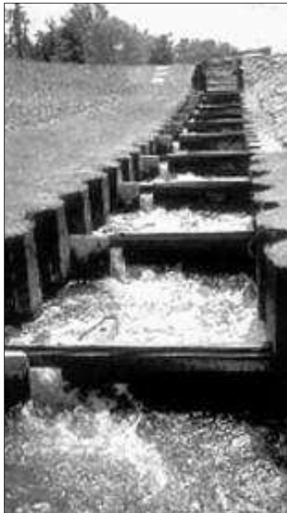
Medencés hallépcsők a Steir-folyón (Larnier és mtsai, 2002 nyomán)
