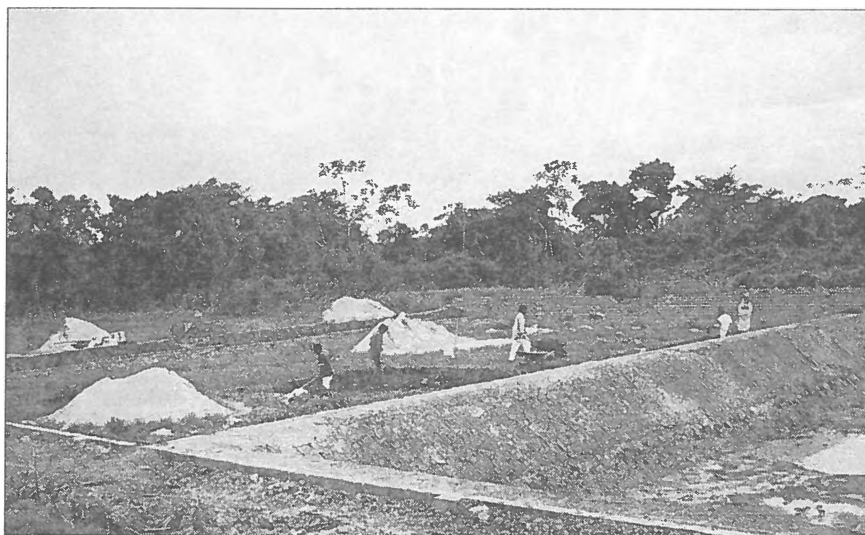
Anyahalas tavak épülnek a Mausa telepen. A tavak töltésébe 1,5 m magas téglafalat építettek, hely és töltésanyag megtakarítás céljából (Dr. Woynarovich Elek felvételei)
