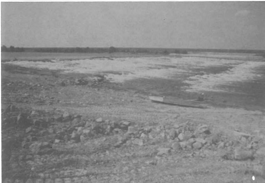
A Duna 1843 fkm szelvényében épített fenékküszöb
