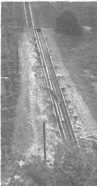
A balatonaligai főnyomóvezeték építése
