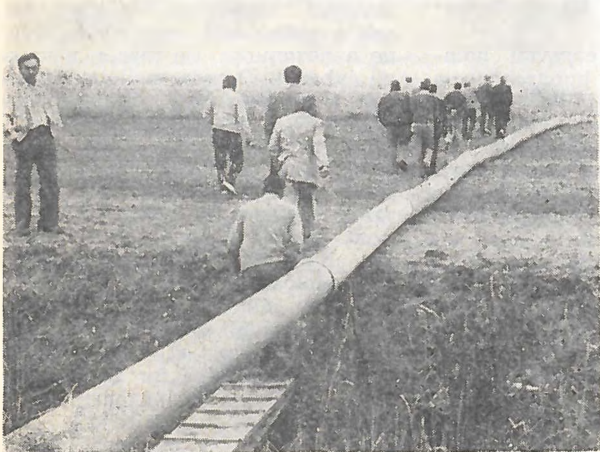
A szakemberek megtekintik Dávodon a műanyagcsőből a terméketlen talajra juttatott halastavi iszapfeltöltést
