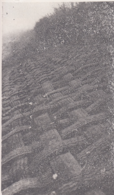
1. kép. Fonatos partvédelem (lazább megoldás)
