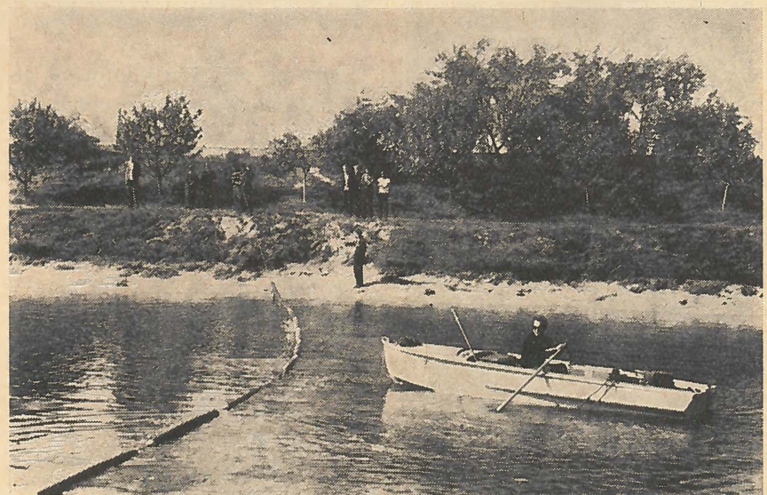
Az ERG 1—8/1 elektromos halterelőt 6 fő kezeli üzem közben
