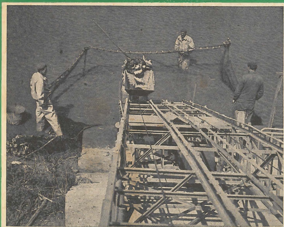
A lehalászás gépesítésének fontos eszköze a villanymotoros halkiemelő. Tökéletesített formája a hálóból a válogató asztalra vagy emberi munka nélkül a szállítóeszközre képes a halat továbbj. itatni
