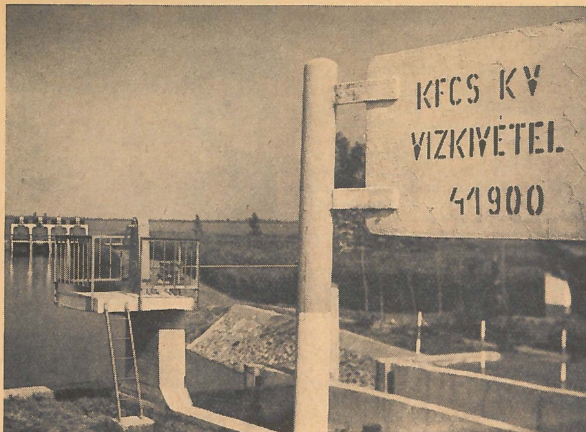
A KV. tározó vízkivételi műve
