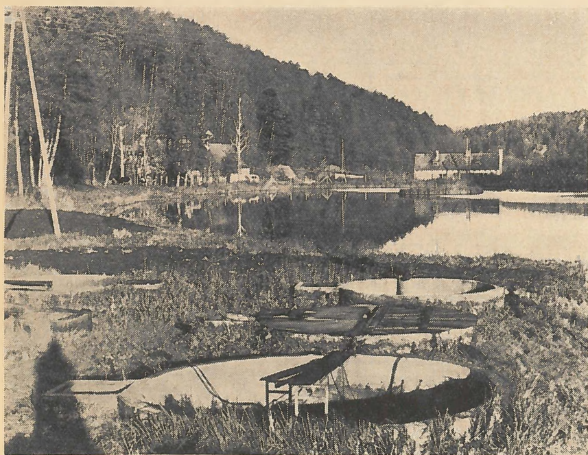
Szlovákiában sok kis festői pisztrángos tavacska üzemel. Előtérben körfolyásos betonmedence
