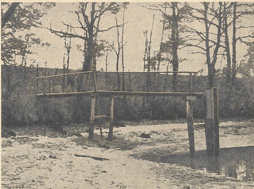
Az ilyen — tölgyfából készült — lecsapoló zsilip nem tekinthető korszerűnek. Cseh-szlovákiaiában sok hasonlóval találkozunk. Persze a termelési eredmények nem a műtárgyakon múlnak...
