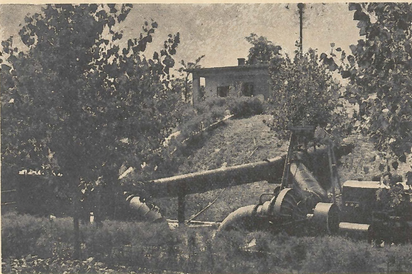
Állandó jellegű DCSK gépcsoportú szivattyúállás
