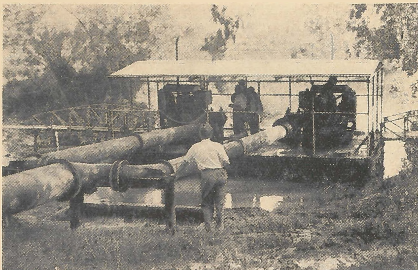
Félig hordozható úszóműves szivattyúállás
