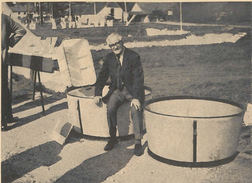
500 l irtartalmú műanyag kádak. A megfelelő vasalás jóvoltából elnyúthatóknak, súlyuk mindössze 35 kg (a csehszlovák kiállítás újdonsága)
