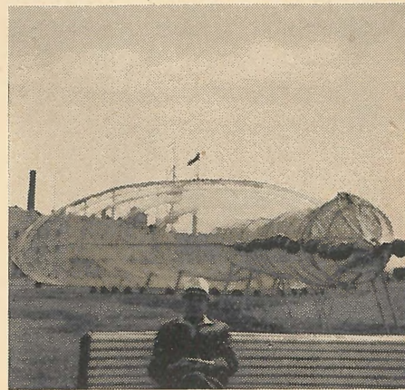
18×16 m nyílású, 2458 kg súlyú trawler háló
