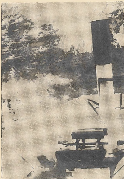
Hidraulikus vízszintszabályozó zsilip (kísérlet; Balogh felv.)
