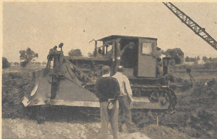
Töltésépítés dózerrel
