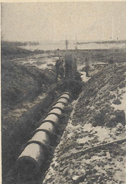
Lecsapoló zsilip építése
