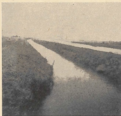
Magas vezetéki csatornából anyagárokba átszivárgó vízvesztés
