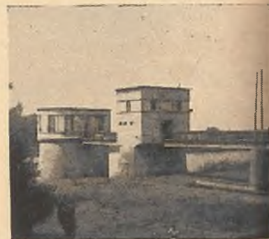
A hódmezővásárhelyi szivattyútelep
