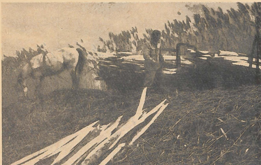
A gazdasági kisvasút jó szolgálatot tesz a töltésvédelem karóinak gyors szállításakor (Tölg felv.)
