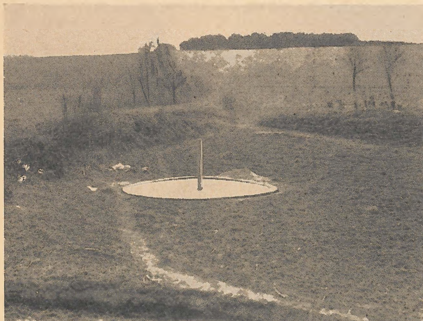
Betonozott etetőhely Iregszemcsén a takarmányfelvétel jobb ellenőrzése végett (Jászfalusi felv.)
