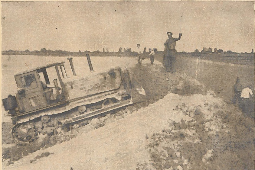
Gépesített töltésépítés
