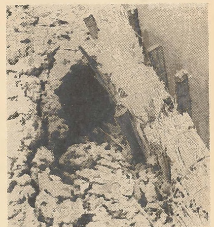
Ilyen kiüregelődések keletkeznek, ha a bevédésnél nem alkalmazunk enyhe lejtésű földterítést, amelyen a hullámok kifuthatnak. (K. V. tározó Balmájúváros) (Fóris felv.)
