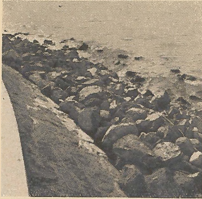
Habarcscsal kiöntött terméskőfalazat nagyobb tavak partvédelmének (ehelyett kiöntés nélküli hézagolást javasolunk kavicsagyazattal)
