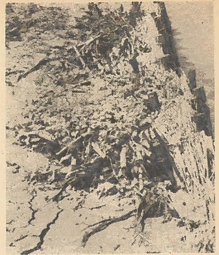
Részben kijávitott elhabolások a K. V. tározó jászólgátak bevédése mögött
