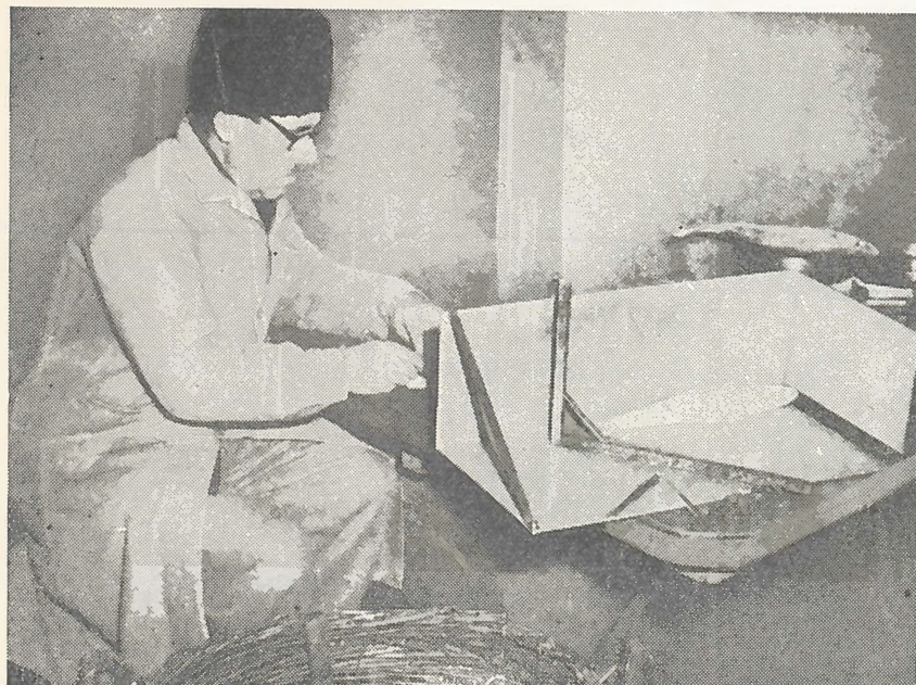
A stülök lemérését is megkönnyíti a módosított Vámosi-féle halmérő láda (Tölg felv.)
