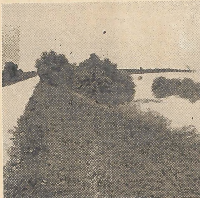
A Csík tároló rézsűvédelme (Sovjetunió) rözszeborítással és faültetéssel. A fűzfa megfigyelések szerint négyhónapos elborítást is kibír. (Tiszai felv.)
