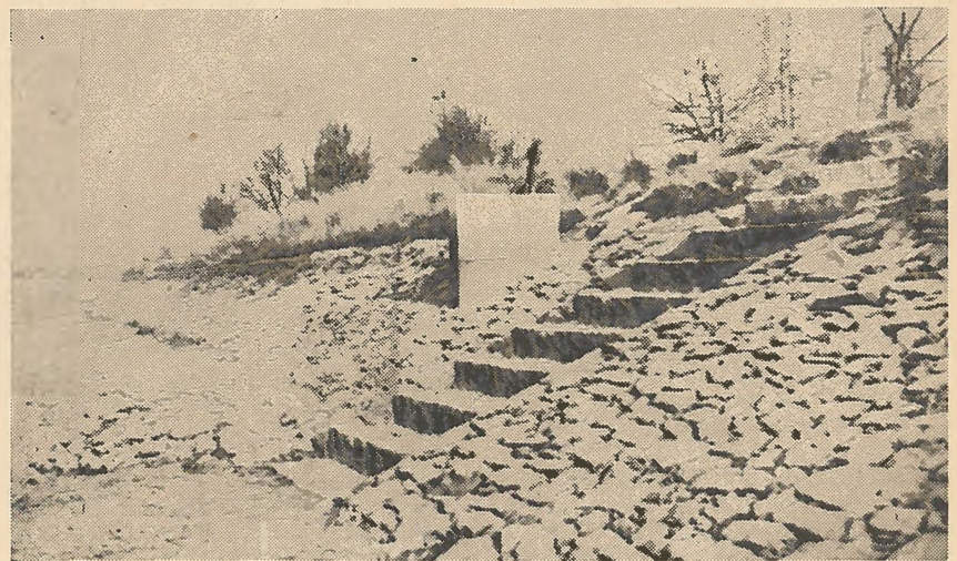
Csehszlovákia tógazdaságaiban ilyen köburkolatot alkalmaznak a hullámvérés ellen, a kiürítő zsillipek mellé pedig széles betonlépcsőket építenek. (Fóris felv.)
