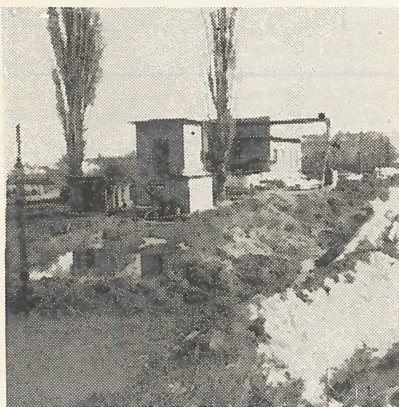
Szekszárd városi szennyvíztelepről a tisztítatlan szennyvíz közvetlenül jutott az elvezető csatornába. Átalakítás miatt a derítőket nem működtetik. (Donászy fe'v.)
