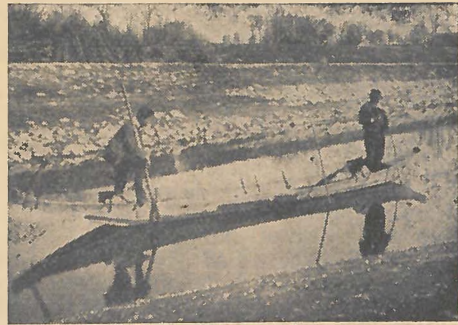
8. kép. A karó leverése a „sulyokkal”.
