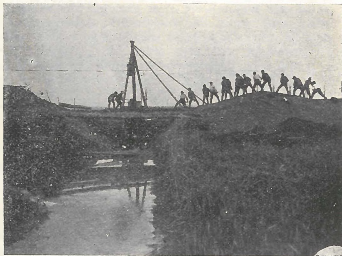
3. ábra. A czölöpök beverése istrángos verővel. (Iharos, Somogy vm.).
