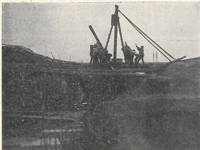
2. ábra. A czölöpök beállítása a dobogóról (Iharos, Somogy vm.).
