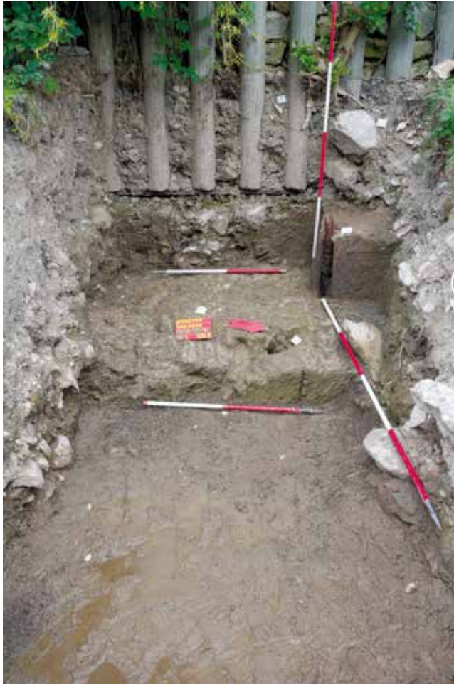
1. kép: A várak nyugati oldalán (18/1. szelvény) található, a kontrafal építése során kialakított egykori befolyó az 1970-es években kialakított betoncölöpökkel
