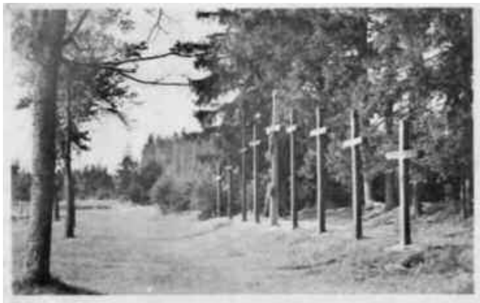
2. Kríže na pohľadnici (okolo roku 1935) ešte pred vybudovaním hlavnej cesty č.168. ( http://img5.rajce.idnes.cz/d0509/0/10/10015_e84b4e77516a0bf138dce2251effb86d/images/1935,asi_-_Devet_krizu_u_Hlubokeho,_Velka_Bites_.jpg )
