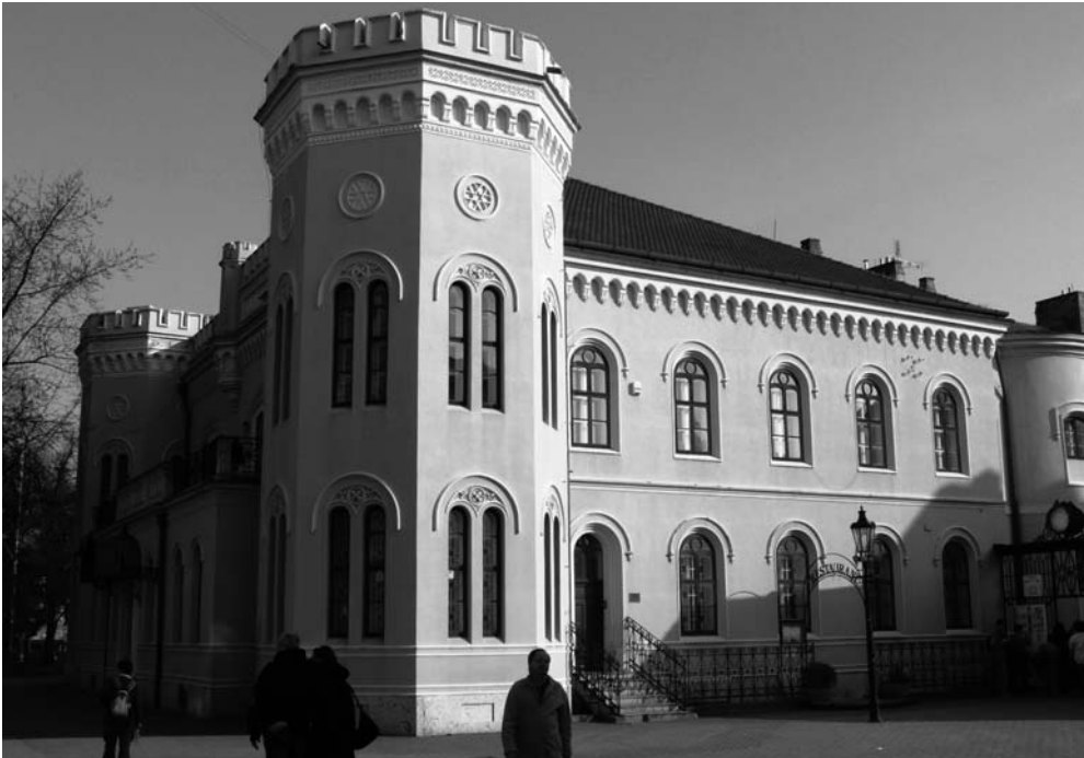
A Tiszti Pavilon épülete a Klapka tér felől. Az emeleti részben található az Etnológiai Központ (L. Juhász Ilona felv. 2008)
