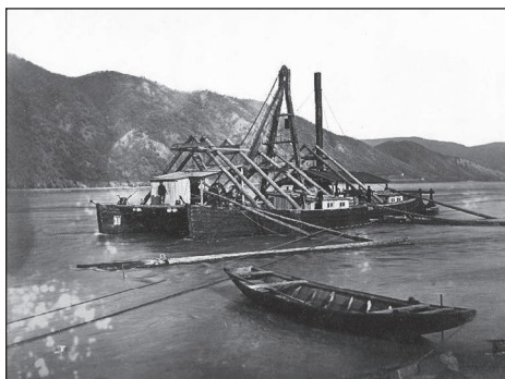
4. kép. Látkép. Gőzüzemű sziklazúzó képe az Al-Duna 1890-es évekbeli szabályozásának idején. Forrás: http://kereso.dunamuseum.hu/product.php?id=38609 (Letöltés 2020. 07. 14.)
