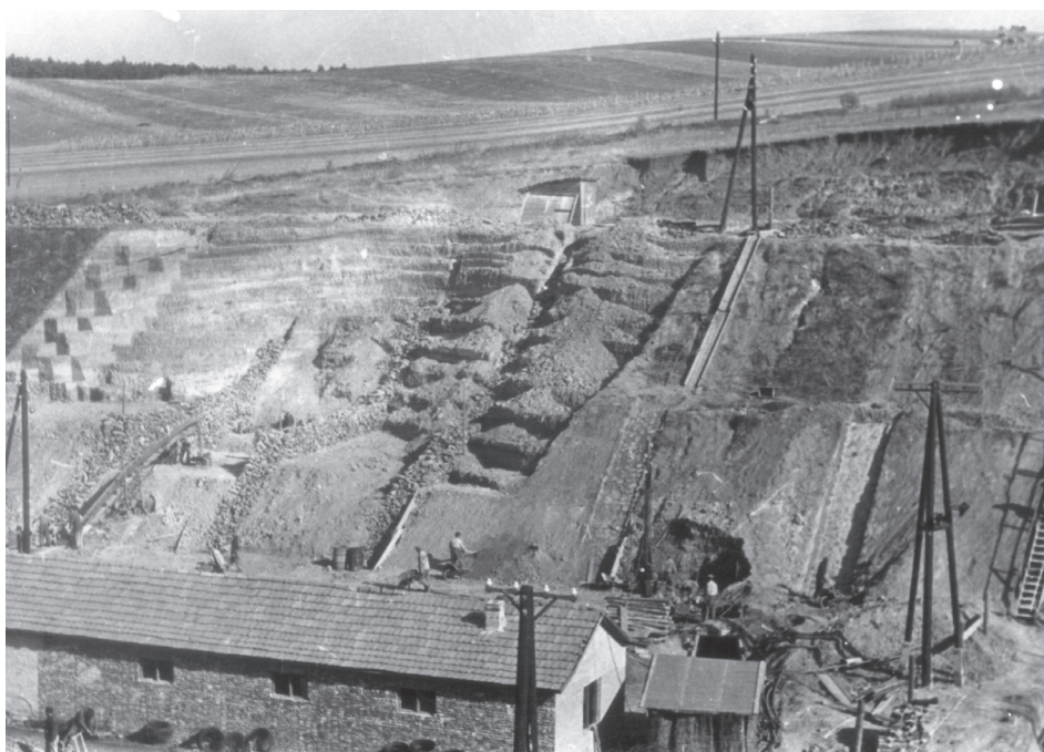
A rézsű kialakítása. Puskás Pál felvétele, 1956
