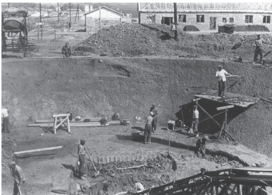
A 100 méteres kémény építése előtti földmunkák. Puskás Pál felvétele, 1955
