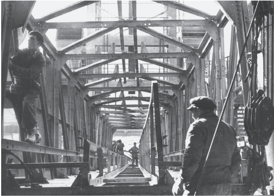
Az adagoló, hűtő és tároló közötti szállítószalag-rendszer munkálatai Puskás Pál felvétele, 1957
