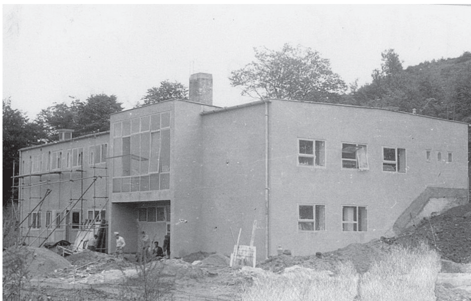
Az épülő 500 fős munkásfürdő
