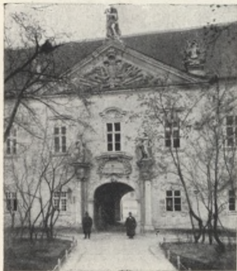
Fig. 17. Facciata settentrionale dell'Armeria ora demolita.
