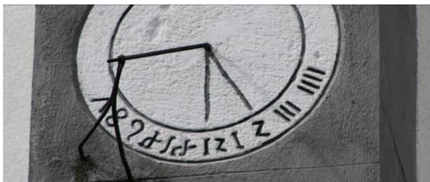
27. ábra. A dipsei gótikus templom napórája (1489): 1,8,9,X,IX,1Z,1,Z,III,IIII .
