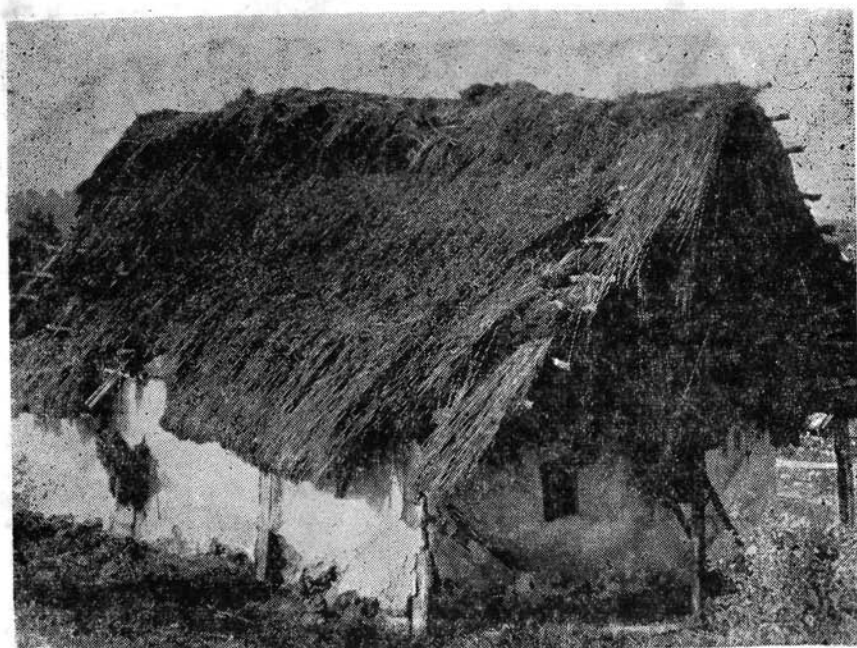
11. A Dózsa utca 61. sz. alatti füstöskonyhás talpasház horidokzata és a telek felőli oldala
