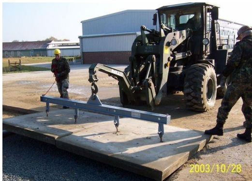
2. ábra Előre gyártott pályaelem beemelése [17]
