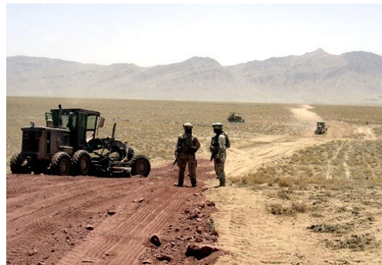
Megközelítési út építése 19
