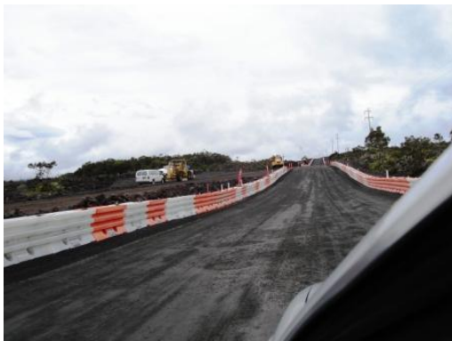
Ideiglenes út építése 18
