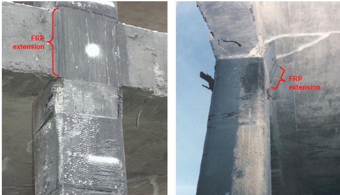
3. kép Erősítőcsíkok túlnyújtása az oszlopokon
