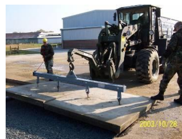
Előre gyártott elem beemelése
