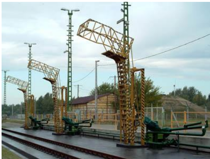
10. ábra: Korszerű vasúti üzemanyag lefejtő rendszer a kecskeméti repülőtéren 16
