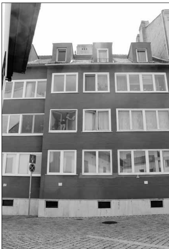
6. kép. Orsolya tér 1. Építész: Erdeős László, 1962.
