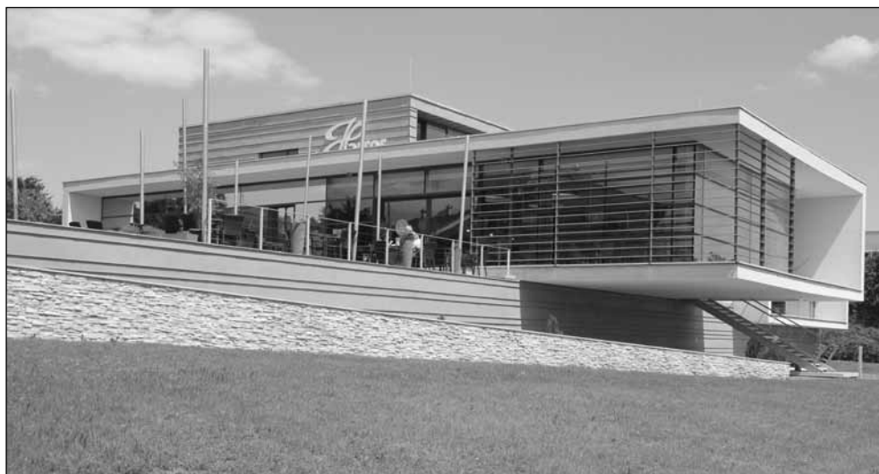
2. kép. Harrer csokoládéüzem, Faller Jenő u. 4. Építész: Christoph Huber, helyi építész: Kiss Gábor Árpád. Építés éve: 2008/2009., Winkler Oszkár-díj: 2010. Bolodár Zoltán felvétele
