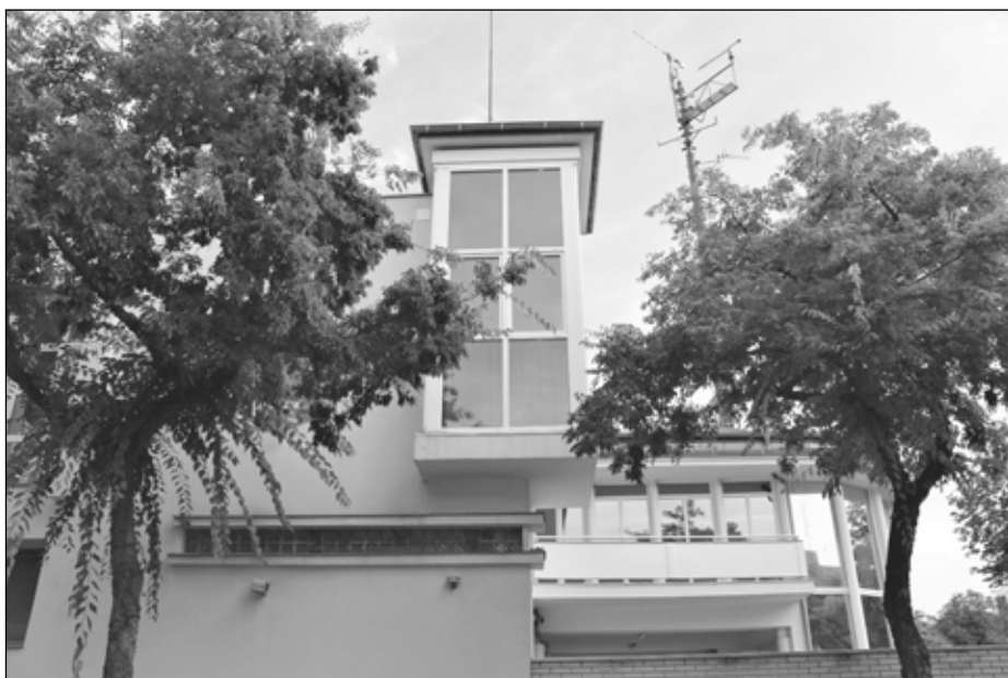
34. kép. Stauer villa, Hirközlési felügyelet. Építész: Viszlai József, 1998.
