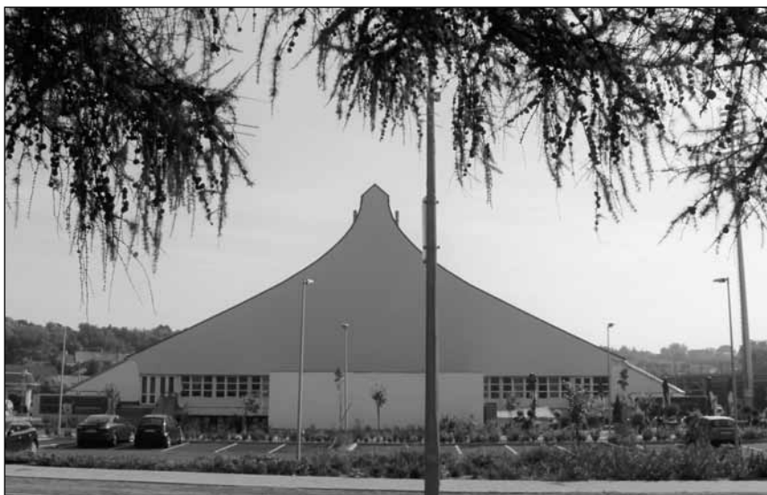
28. kép. Sportcsarnok. Építészek: Kiss Imre, Kangyal Ferenc, Kangyal Tibor, 1988. Rétegelt, ragasztott háromcsuklós tartók
