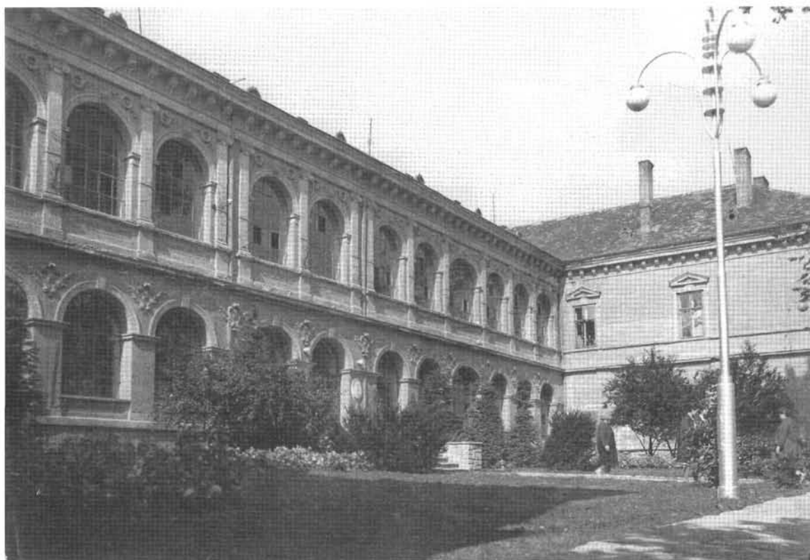
8.kép: Az épület udvari homlokzata 1970-ben. (Göcseji Múzeum adattára 594-79/4)
