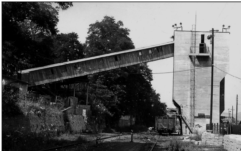
Az 1969-ben épült rudolftelepi vasbeton széntároló és rakodó.
