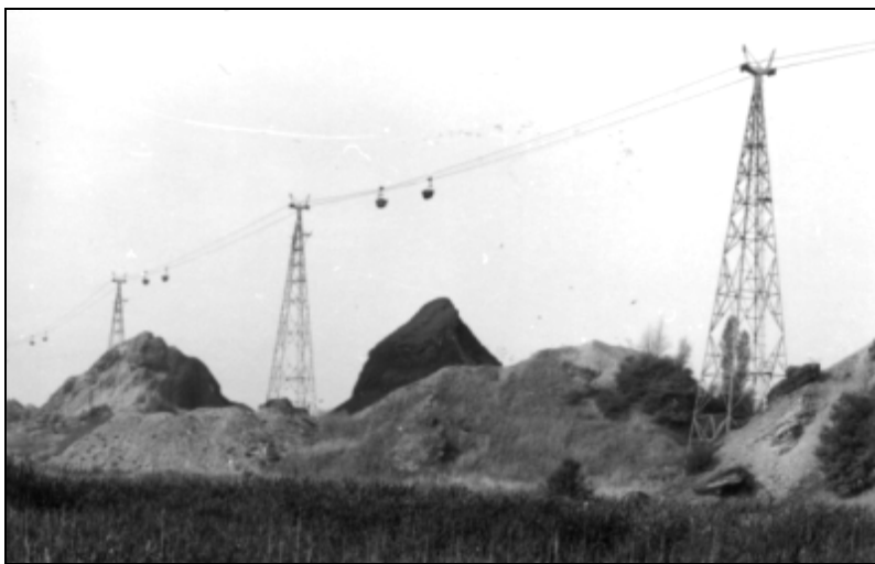
Az Edelény I-IV. akna és a berentei központi szénosztályozó közötti függőkötélpálya, alatta a régi meddőhányók.
