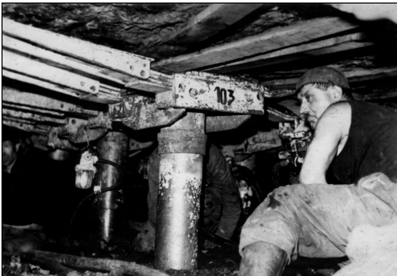
Schwartz-Wild önjáró kerettel biztosított frontfejtés.
