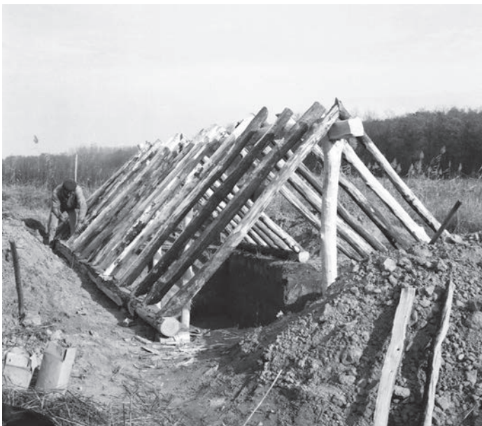
31. kép Leveleki földdől ( burgyé ) építése, 1993 (fotó: Páll István)
