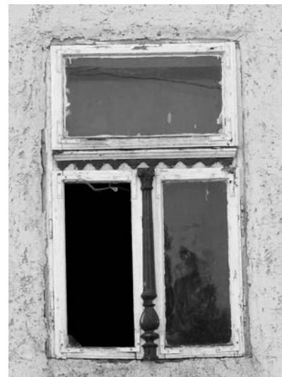
43. kép Petőfi S. u. 25. (Függelék 47.) Fig. 43 Petőfi S. Street 25 (Appendix 47)
