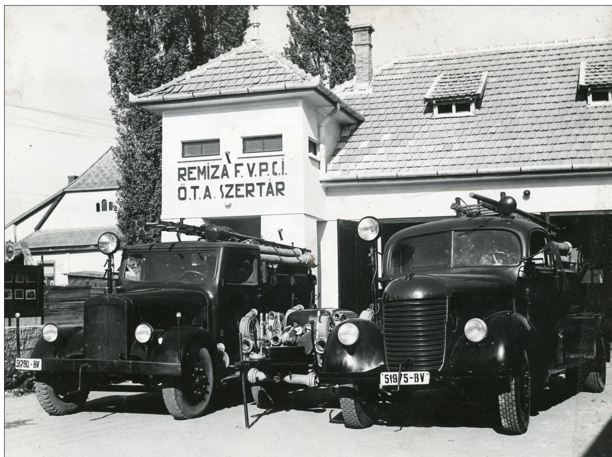
44. ábra Az önkéntes tűzoltók autói az általuk épített szertár előtt (1960-as évek) – ILCM fotótár
