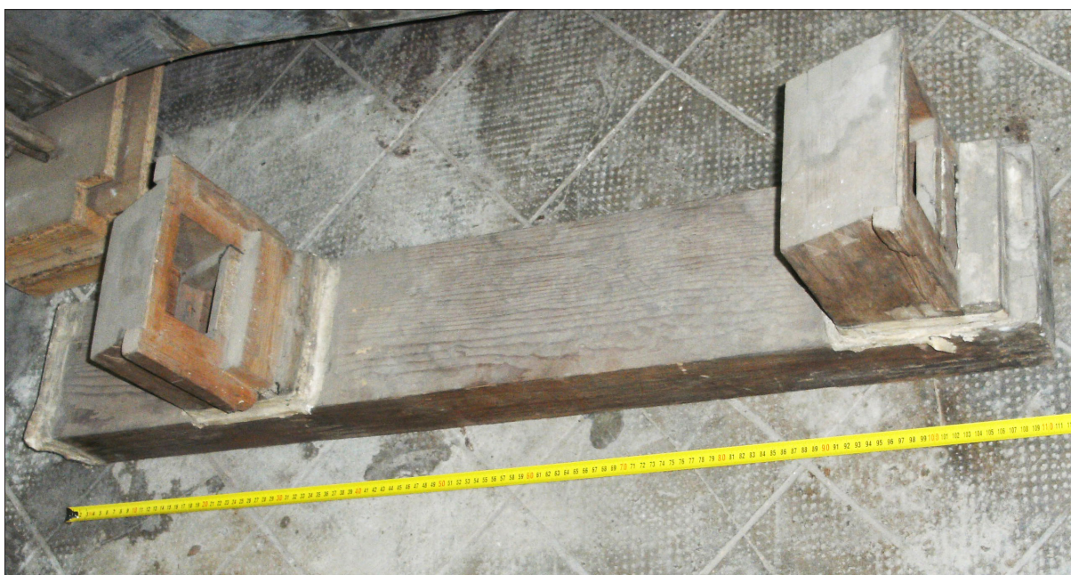
13. ábra A fűvókhoz csatlakozó szélcsatorna
