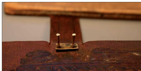
103. ábra A szíjleszorító lemez rögzítése
