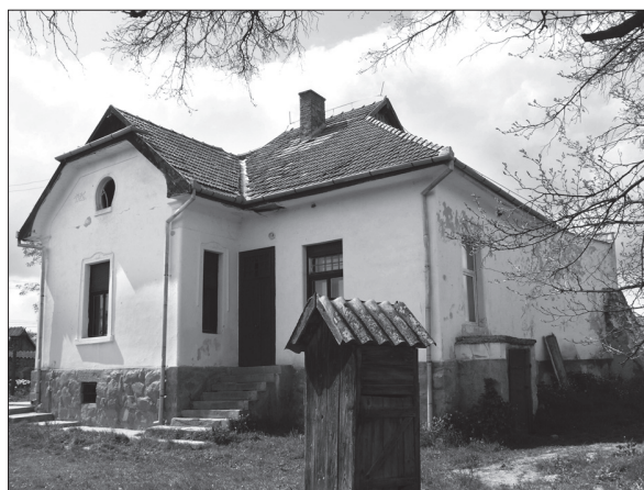
2. ábra Az iskola keleti homlokzata.
